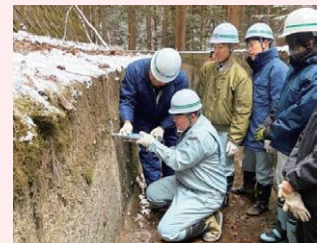
水路補修対策演習の様子
