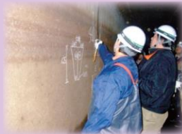
用水路の機能診断
