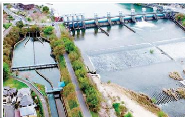
▲明治用水頭首工
