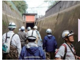
施設の機能診断
