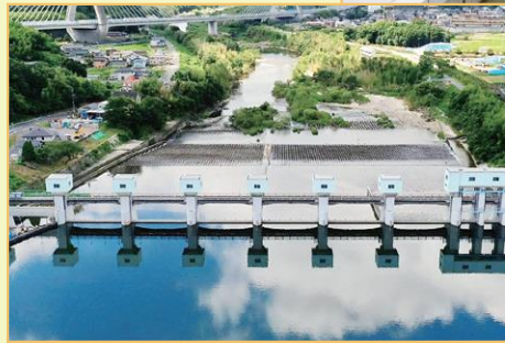
▲明治用水頭首工
