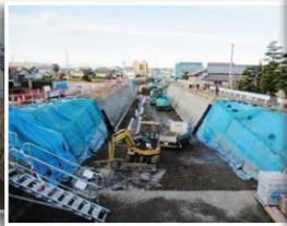
▲水路工事状況
