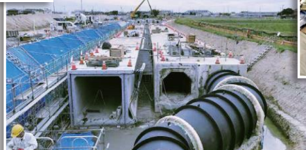
用水路の改修状況▶
