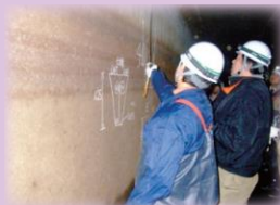
用水路の機能診断
