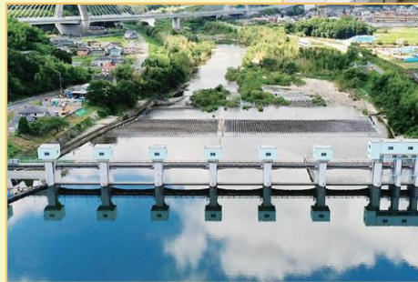
▲明治用水頭首工
