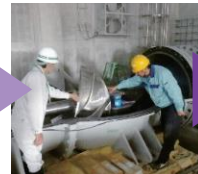
工事の監督・検査
