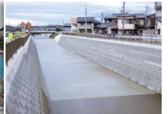
▲整備された水路
