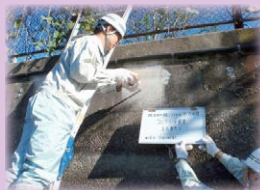
用水路の機能診断
