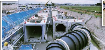
用水路の改修状況▶
