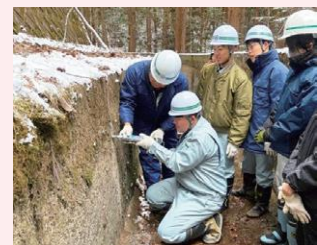
水路補修対策演習の様子
