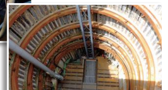
シールド工事立坑▶
