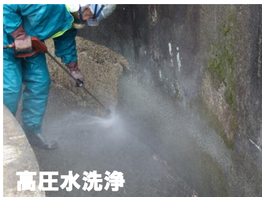
劣化部除去工
