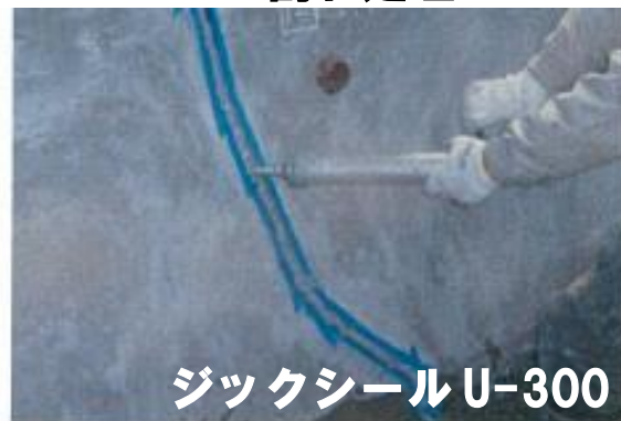
ひび割れ処理工
