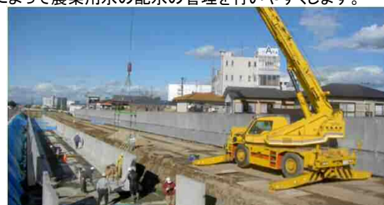
L型のコンクリート二次製品を据付しているところです。
