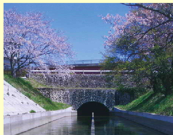
建設当時の姿を残す樋管
