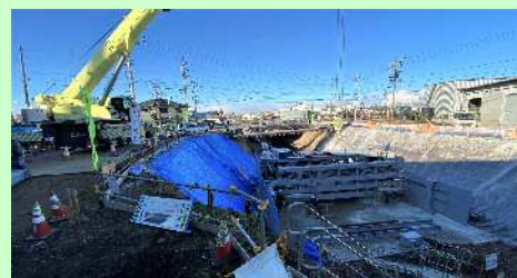
オープンピット工法メッセルシールド機組立状況
