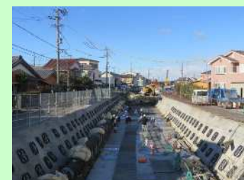
基礎コンクリート施工状況
