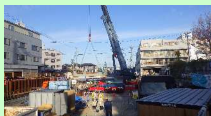
二次製品水路据付状況
