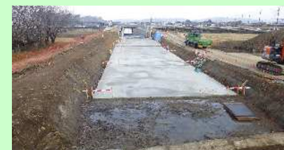
基礎版打設状況
