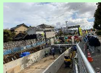
二次製品水路据付状況
