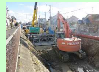
オープンピット工法による掘削状況
