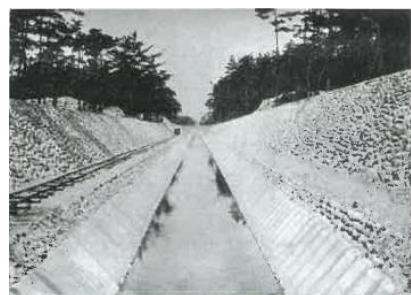
羽島用水の旧水路
