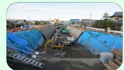
施工中の様子
