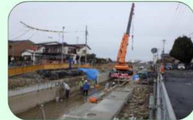
施工中の様子
