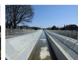
施工後(上流より)
