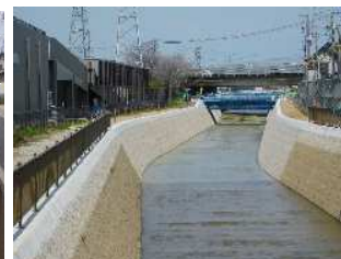
施工後(下流より)
