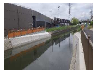
施工前(下流より)
