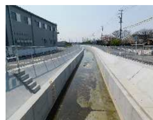
施工後(上流より)
