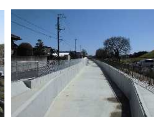
施工後(上流より)
