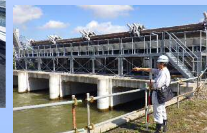
施設状況確認
