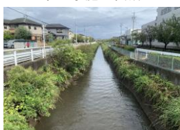
本工事施工箇所
