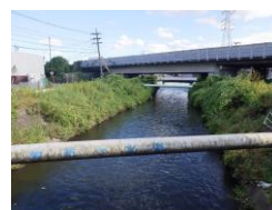
本工事施工箇所
