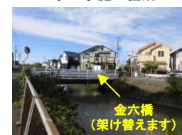
本工事施工箇所
