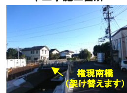
本工事施工箇所
