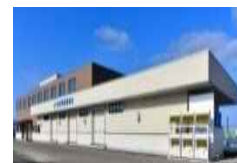
集出荷・貯蔵・加工施設の整備
