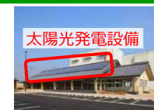
太陽光発電設備
