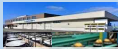
集出荷・貯蔵・加工施設の整備
