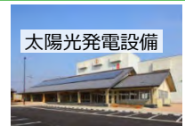
太陽光発電設備
