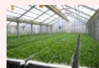
農業生産施設（水耕栽培ハウス）
