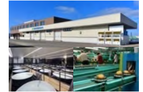
集出荷・貯蔵・加工施設
