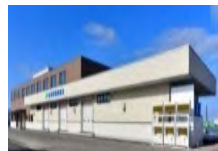
集出荷・貯蔵・加工施設の整備
