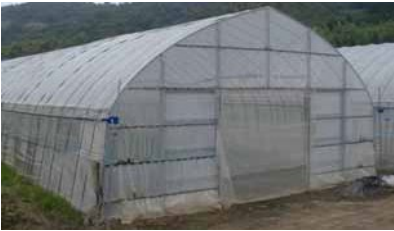
パイプハウス
