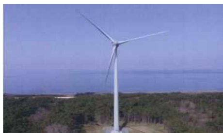
風力発電所 高さ：112m、ブレード直径：82m
