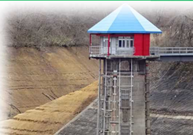
改修予定の「あいののダム」の取水塔
