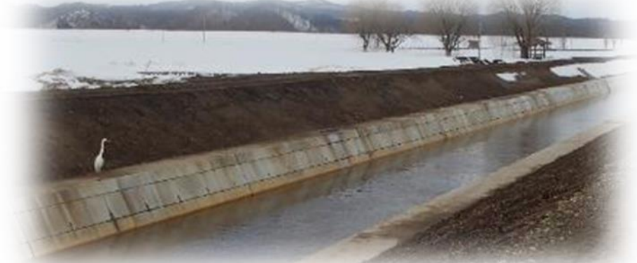
改修後の油川幹線排水路
