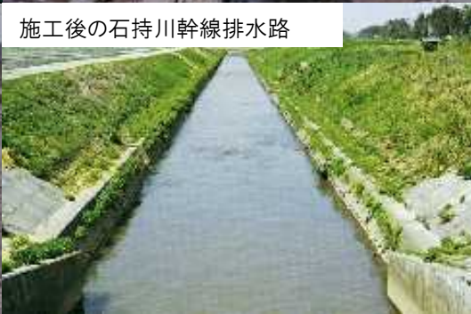
皆瀬1号幹線用水路
