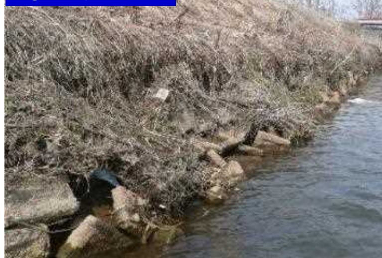
④ 油川幹線排水路
