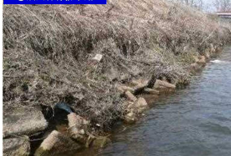
④ 油川幹線排水路
