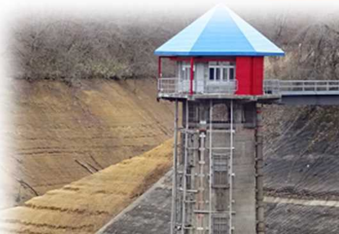
改修予定の「あいののダム」の取水塔
