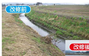
皆瀬4号幹線用水路
