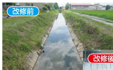
皆瀬1号幹線用水路
