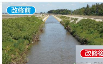
油川幹線排水路
