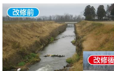
大宮川幹線排水路
