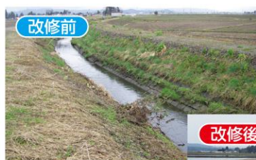
皆瀬4号幹線用水路
