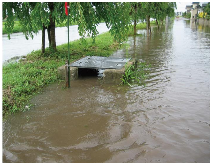
石持川幹線排水路隣接道路の冠水被害
