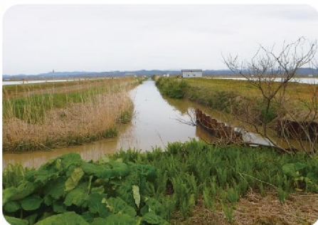
A1支線排水路
