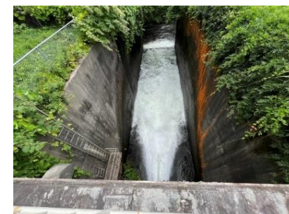
葛丸ダムの放流状況 (R7.8.14)
