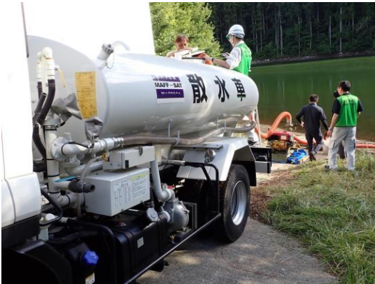
散水車への給水
