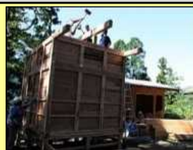
板倉建築の組み立体験
