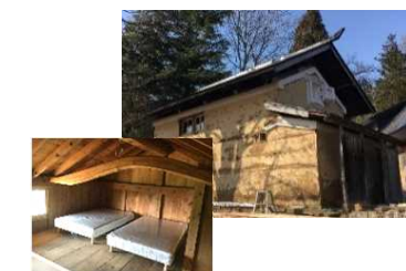
改修後の蔵 写真上:外観、下:内観
