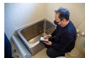
民泊開業予定 住宅調査
