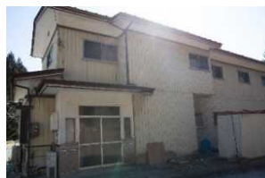
民泊開業予定 住宅調査
