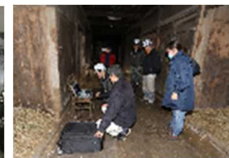
↑【写真3】耐震診断調査
