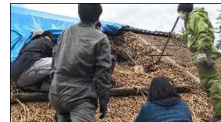
茅葺き屋根の葺き替え体験
