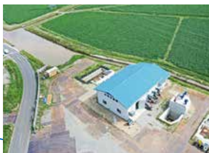
▲広瀬沼機場（宮城県）
