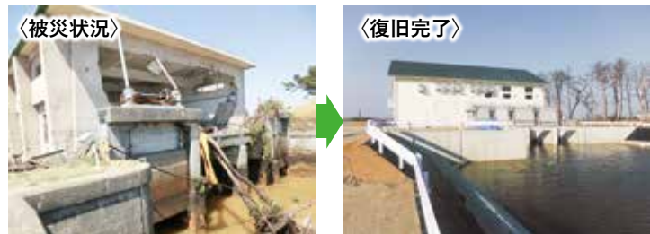
【▲高砂南部排水機場】
