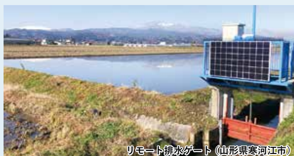
自動給水栓による水管理（山形県鶴岡市）
