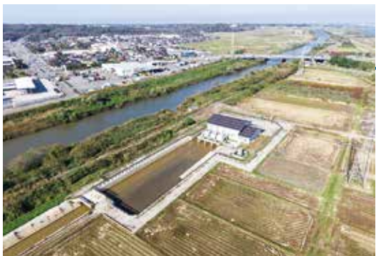
▲中央排水機場 (山形県)
