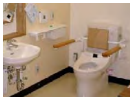
【手摺りつきトイレ】
