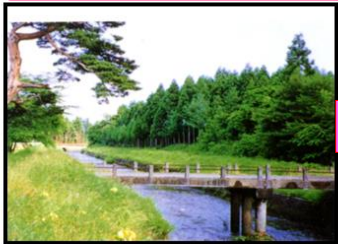
【改修前の水路の状況】
