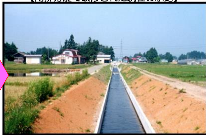
【改修された現在の水路】
