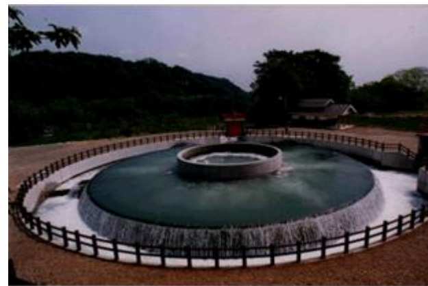
【平成9年（1997）改修の現在の 円筒分水工】
