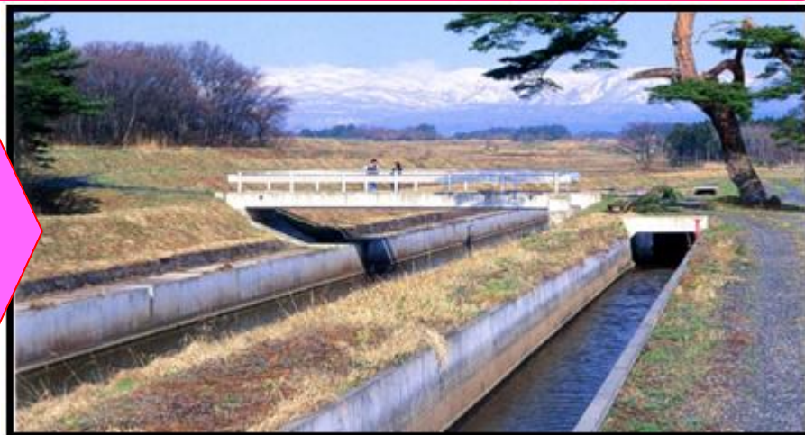
【用排分離で改修された現在の水路】
