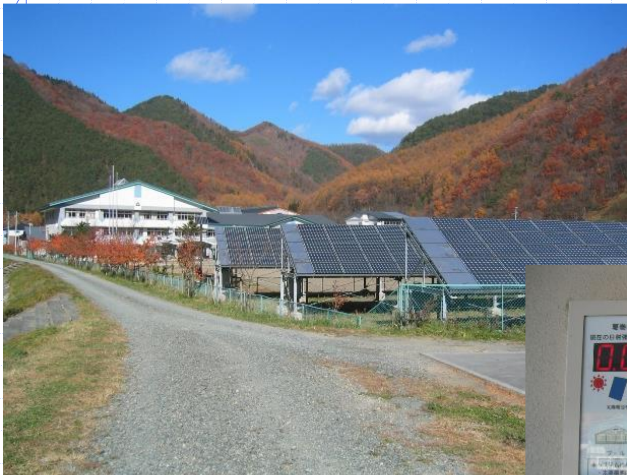
葛巻中学校太陽光発電設備(50kW)
