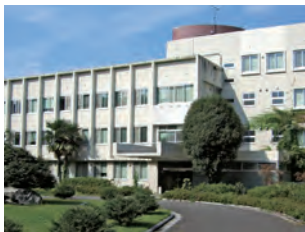
西ヶ原本所庁舎
