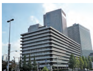
中央合同庁舎第4号館へ 移転(2008年)
