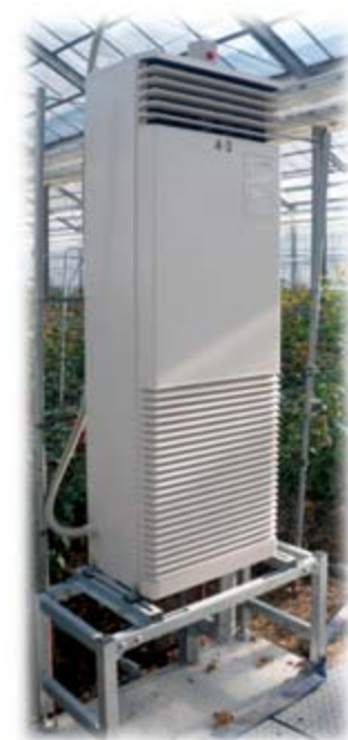
写真1 バラ栽培温室内に設置されたヒートポンプ
