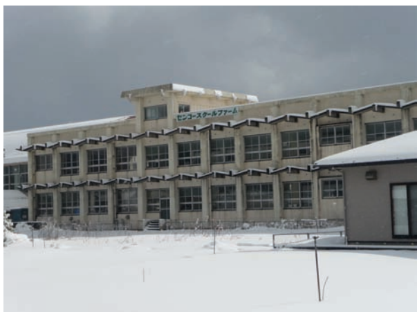
写真 6 社屋（廃校となった小学校を利用）
