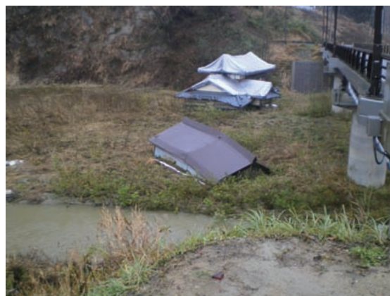
写真2 河道閉塞で水没した木籠集落の住宅
