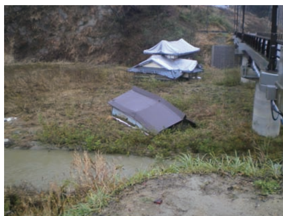
写真2 河道閉塞で水没した木籠集落の住宅
