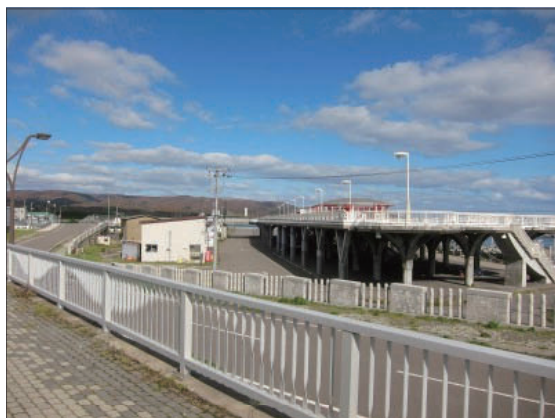
写真11 人工地盤から橋を通過して下町へ
