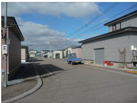
写真5 望洋台の住宅
