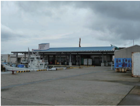
写真5 冷凍・冷蔵施設が再整備された阿古港
