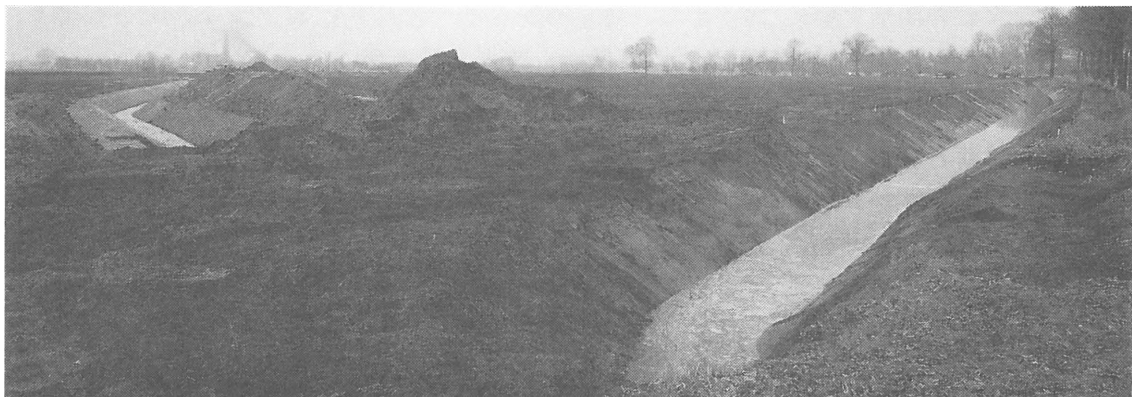
左に見える排水路は埋め立て、右の区画の端に沿って新しい排水路を掘削する。
