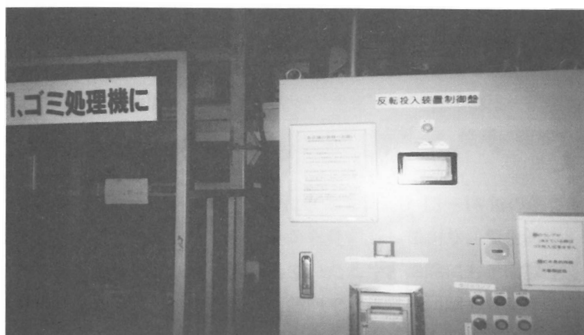
写真5 屋上に設置された生ごみ処理機
