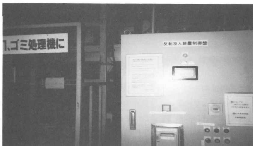
写真5 屋上に設置された生ごみ処理機
