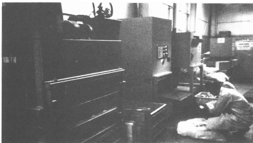
写真 8 ごみ処理施設内部
