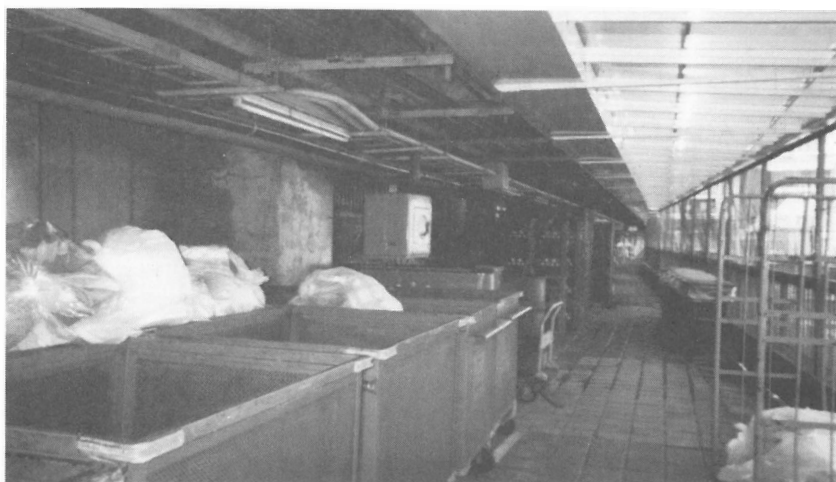
写真3 屋上（9階）のごみ集積場
