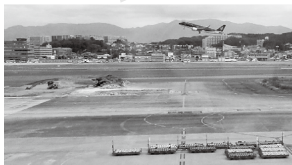
工事中滑走路
