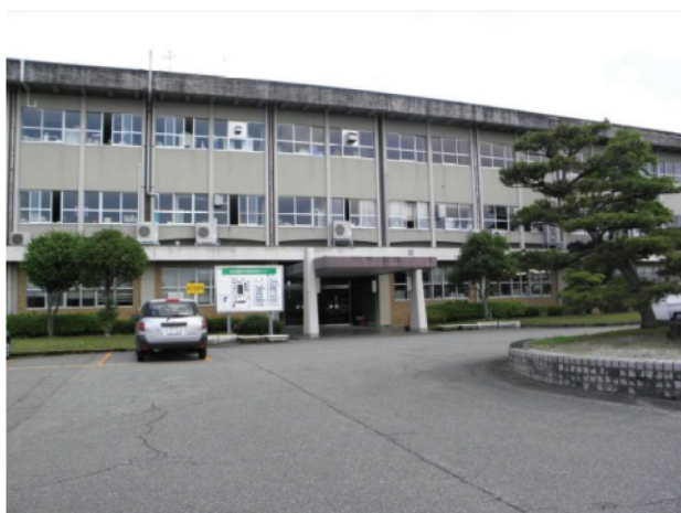
富山県農林水産総合技術センター本館
