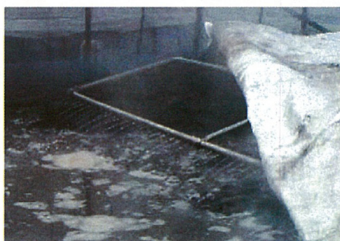
(牽引式での熱水注入状況)
