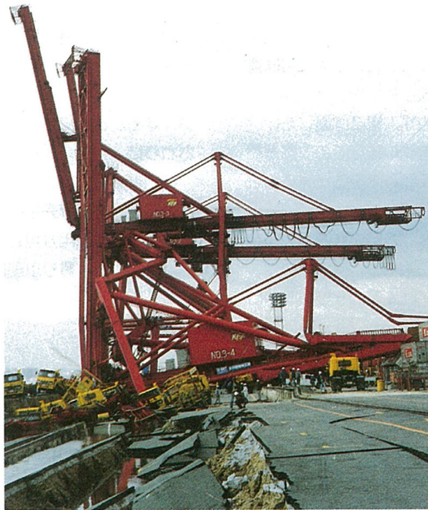
崩壊したエプロン
