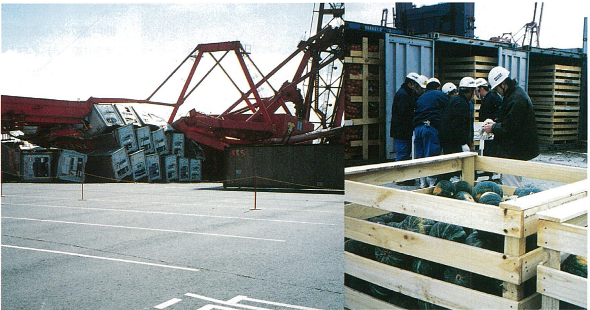
倒壊した大型クレーンと押しつぶされたコンテナ
