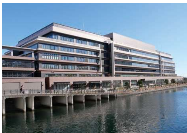
研修センター(よこはま新港合同庁舎内)
