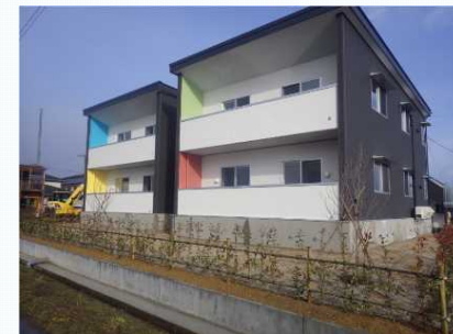
共同住宅（福島県河沼郡湯川村）
