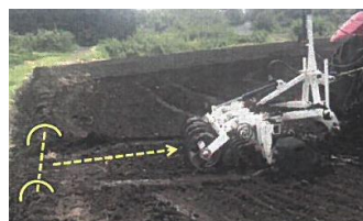
ほ場面の傾斜・均平化作業
