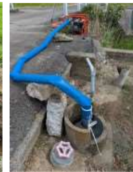
応急的な取水のため用水路の充水
