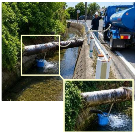
幹線水路の落水を取水
