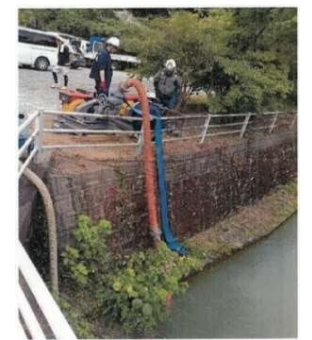
給水車用の 応急取水ポンプ設置
