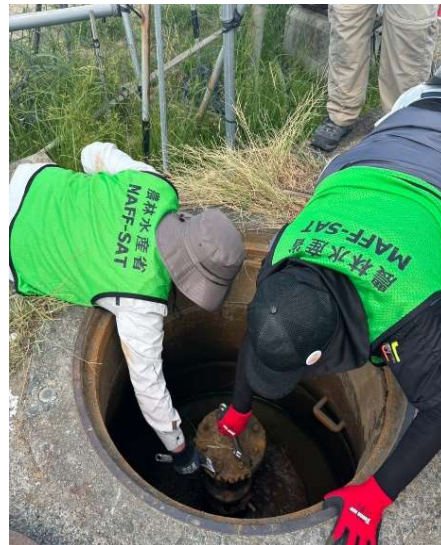
MAFF-SATによる空気弁の点検・確認
