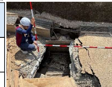
ボックスカルバートの破断
