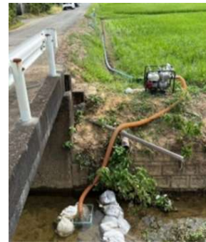
応急的な取水のため用水路の充水
