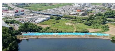
ため池堤体の応急処置（シート張り）
