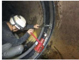
幹線水路の管内面補修状況
