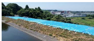
ため池堤体の応急処置（シート張り）
