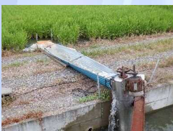
非効率的な揚水状況
