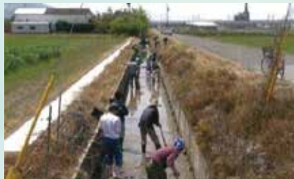
開水路の清掃
