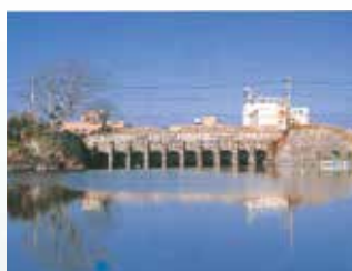
旧郡築新地甲号樋門
