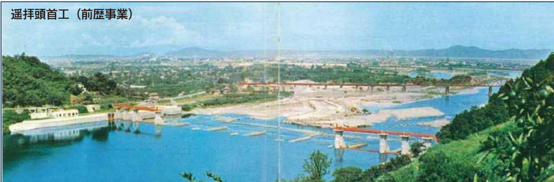
中央部（転倒堰）施工中の様子
