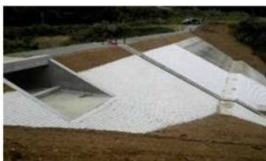
ため池改修等の緊急対策を実施
